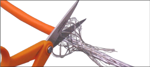
Geflechtschirm zurücklegen ... Fold braided shield backwards ...
