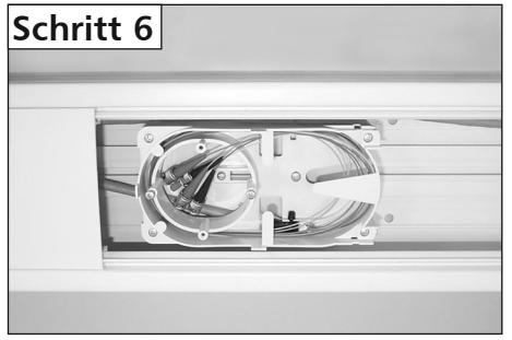
Schritt 6 Stecker bei Bedarf nach Angaben des Herstellers konfektionieren. Reserve aufwickeln.
