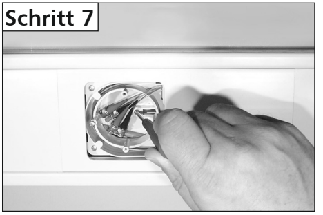
Schritt 7 Kabelkanal schließen. Kabelreservoir justieren und Schraube am Kanalhalter anziehen.
